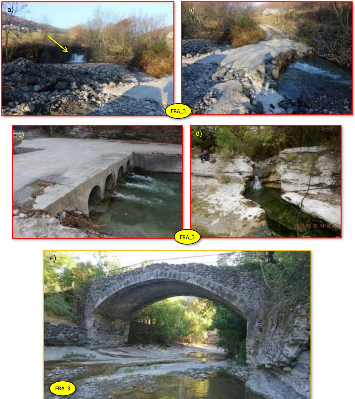
Figure 18 : Perturbateurs anthropiques majeurs (rouge) et secondaires (orange) présents au hameau Les Combes (a) Seuil maçonné d'une hauteur de 3,2 m ; (b) Passage à gué  $\Phi 600$  ; (c) Passage à gué  $\Phi 1000$  ; (d) Seuil maçonné partiellement détruit d'une hauteur de 1,2 m ; (e) Pont Les Combes
