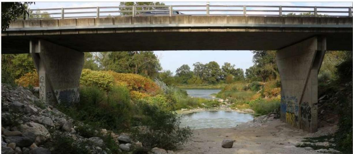
Figure 28 : vue partielle en élévation du pont de la RD 86, on note en aval la confluence avec le Rhône et surtout le décrochement du seuil parafouille partiellement déstabilisé et affouillé.
