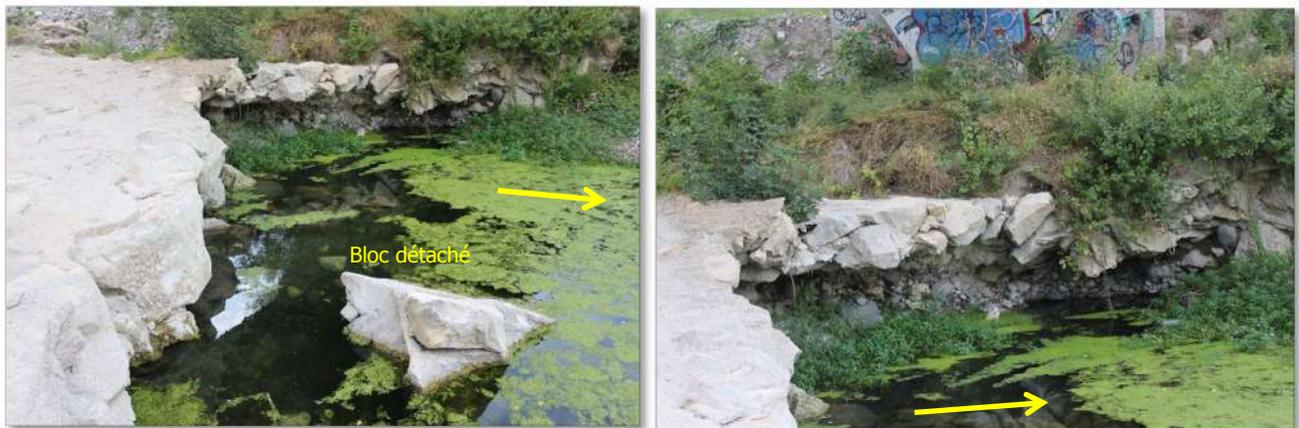
Figure 30 : seuil parafeuille partie aval déstabilisée, le seuil sous-cavé par affouillement se déstructure petit à petit par rétrogradation lors des crues morphogènes. Le ressaut est important (plus de 2 mètres)
