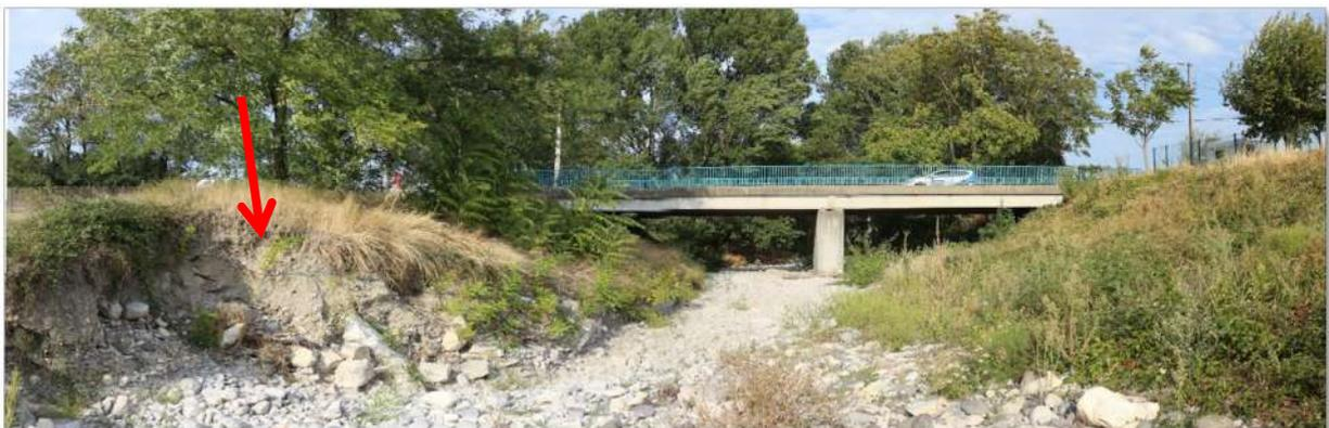
Figure 15 : Vue en élévation amont du pont de l'Europe Unie. On note le rétrécissement de section et le désaxement avec érosion de la berge de rive gauche.
