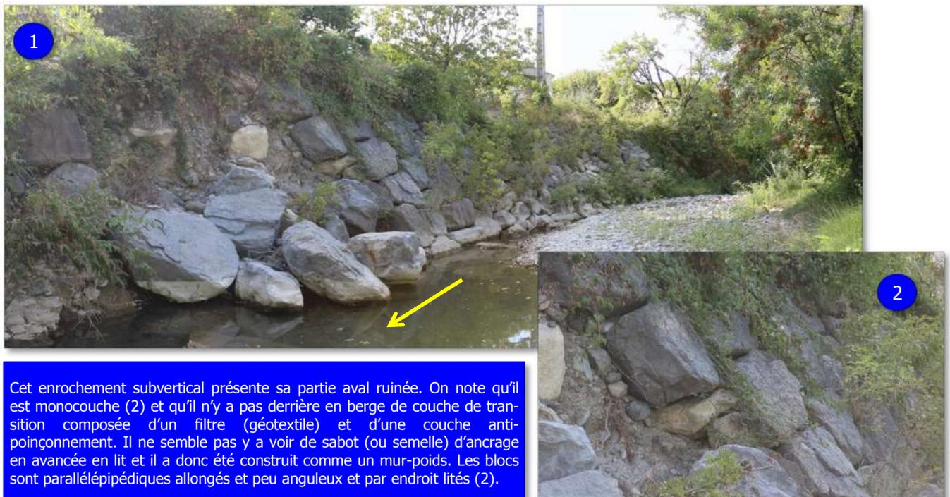
Figure 24 : En haut → enrochement en aval du pont à créneaux partiellement ruiné ; en bas détail de la partie ruinée.
