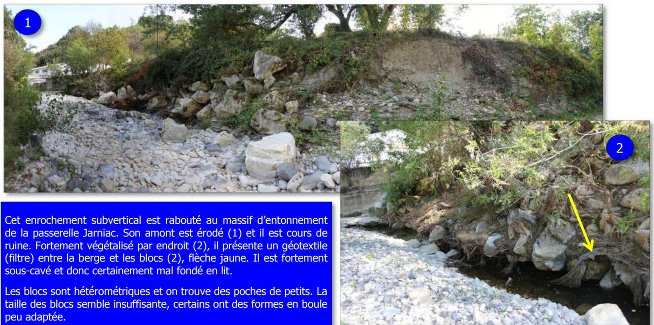
Figure 26 : enrochement en amont raboté à la passerelle Jarniac en cours de ruine
