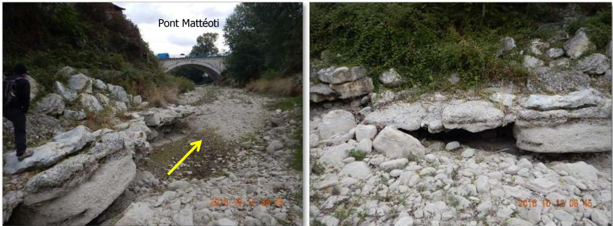
Figure 27 : ouvrage sous-cavé en amont du pont Mattéoti, à surveiller
