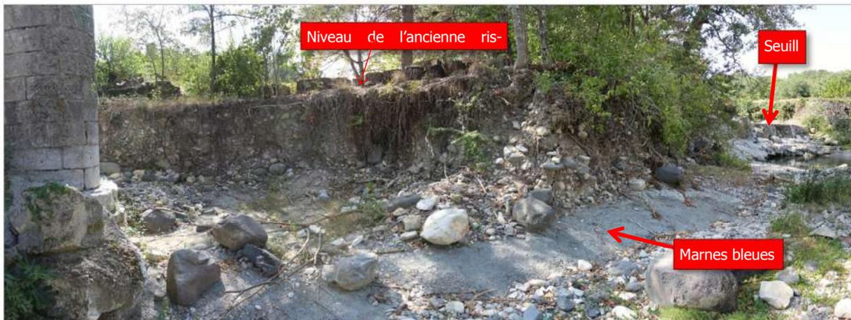
Figure 22 : vue depuis la travée T2 vers l'aval. On distingue le seuil, une passée de marnes bleues du Bédoulien inf. et le niveau de l'ancienne risberme. Cette dernière est érodée du fait de l'incision du lit.
