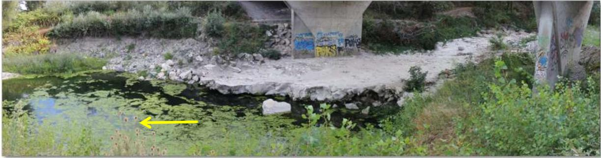
Figure 29 : vue aval RG du seuil parafeuille partiellement ruiné. On note le décrochement important ainsi que l'érosion de berge.
