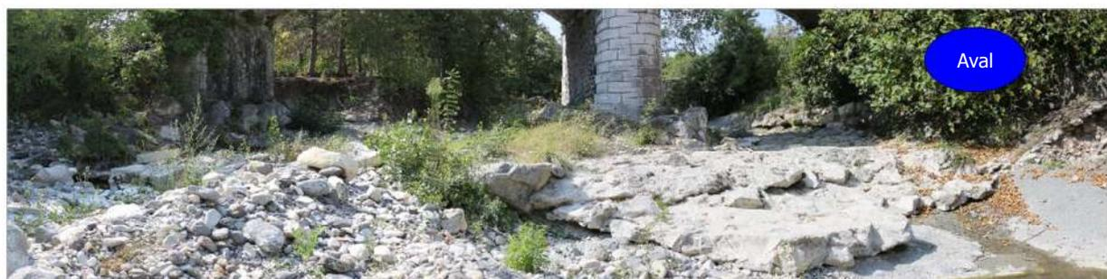
Figure 23 : état du radier parafouille encore visible notamment sous T1, vu depuis l'aval. Il est déstabilisé.
