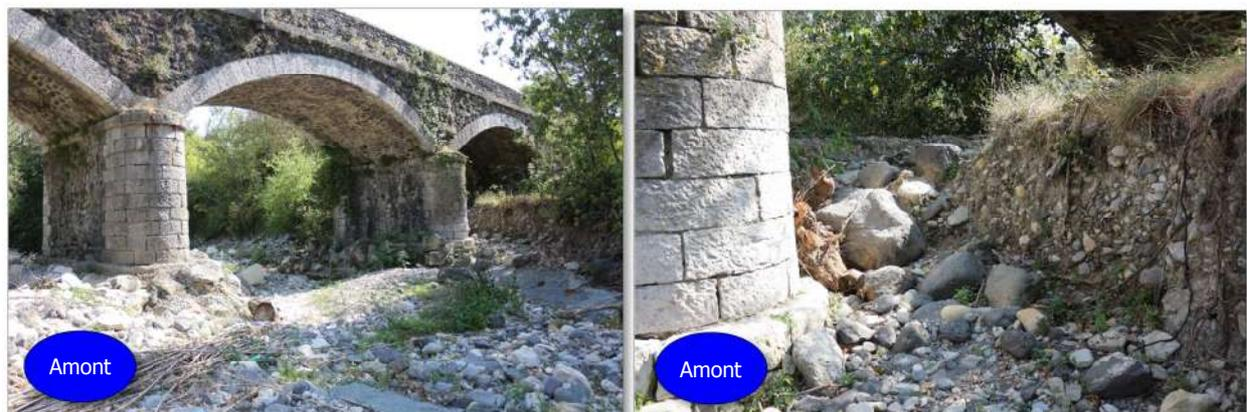
Figure 20 : à gauche → massifs de renforts de P1 et P2, on note T3 obstruée partiellement ; à droite → travée T3 obstruée et l'érosion générée par le passage du Frayol en crue.
