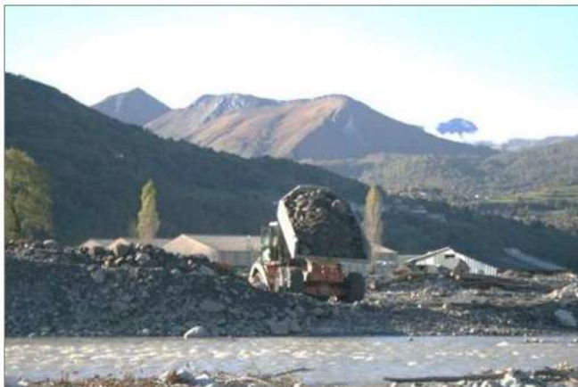
Mise en glacis de matériaux pour une injection-retard (à gauche) et injection-directe sur le gave de Pau (à droite)
