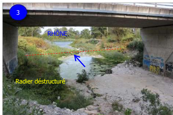
Figure 5 : (1) Vue depuis l'aval, on note l'érosion de berge en aval du reste du radier ; (2) Cette vue montre la fracturation du radier et on voit la forme en cunette pour guider le flux ; (3) La cassure du seuil est bien visible, la confluence est très proche ; (4) le radier apparaît sous-cavé sur cette vue et donc en position de continuer à se ruiner au fil des crues.
