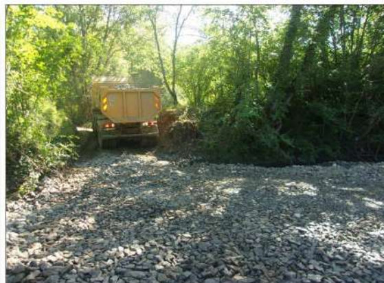
Injection-retard sur un point de réinjection dans l'Aude : 6x4 vidant sa charge (à gauche) et point d'accès par chemin au point de réinjection (à droite) (Hydrétudes pour SMAH de la Haute Vallée de l'Aude, 2017)
