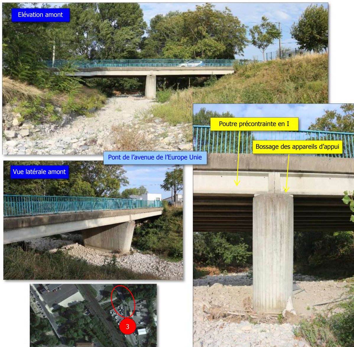
Figure 4 : Pont de l'avenue de l'Europe Unie
