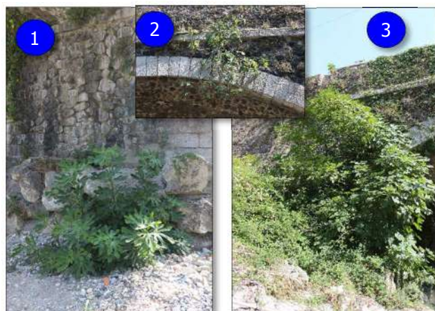
Figure 3 : (1) figuier au pied de P2 sous T2 ; (2) figuier poussant sur le tympan ; (3) figuier en amont de C0 ; (4) figuier âgé en aval de C0
