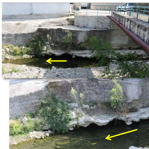
Figure 3 : affouillement de la fondation de la passerelle Jarniac
