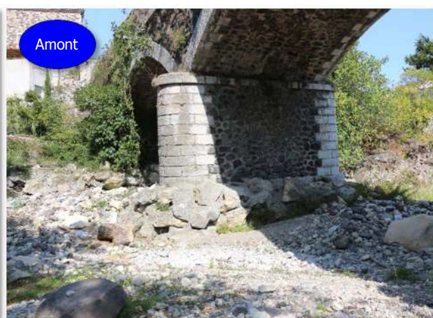
Figure 3 : appuis du pont de la Liberté, à gauche → culée C0 avec massif de renfort sous-cavé ; à droite → pile P1 partiellement reprise par enrochement bétonné
