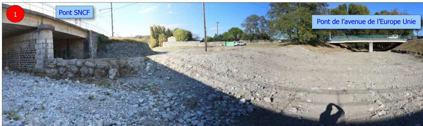
Figure 9 : à gauche → vue de la sortie (aval) de la travée T3 du pont Ch. de Gaulle, à droite → vue de la végétation en amont (arbres sous-cavés à traiter pour limiter un éventuel embâlage de la travée T3 en crue).
