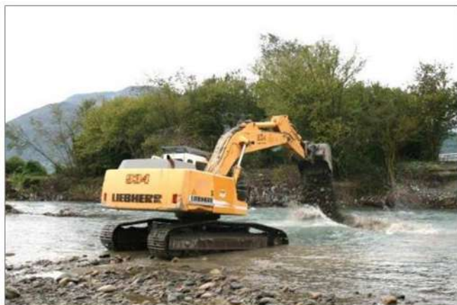
Mise en glacis de matériaux pour une injection-retard (à gauche) et injection-directe sur le gave de Pau (à droite)
