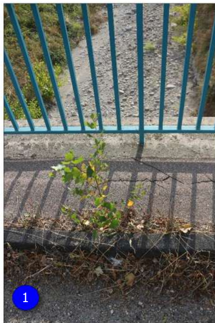
Figure 8 : (1) fissuration du trottoir et peuplier poussant derrière la bordure ; (2) fissuration au-dessus de P1; (3) état du joint de dilatation coté RG.
