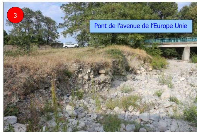
Figure 6 : (1) obstruction partielle de la travée T2 du pont de l'Europe Unie liée aux accrétions générées en RD par le pont SNCF ; (2) accrétions en RD entre les deux ponts ; (3) érosion de berge en aval RG du pont SNCF (zone de réaxement du lit) ; (4) vue depuis la travée T2 du pont SNCF, on voit le mur guideau pour limiter les débordements sur la route, le désaxement et l'érosion de berge
