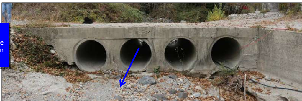
Figure 6 bis : vue aval de l'ouvrage aval
