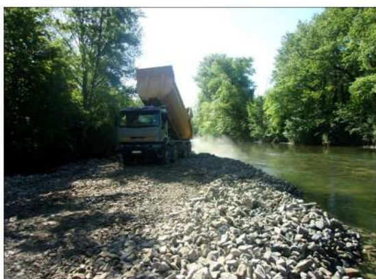
Injection-retard sur un point de réinjection dans l'Aude : 6x4 vidant sa charge (à gauche) et point d'accès par chemin au point de réinjection (à droite) (Hydrétudes pour SMAH de la Haute Vallée de l'Aude, 2017)
