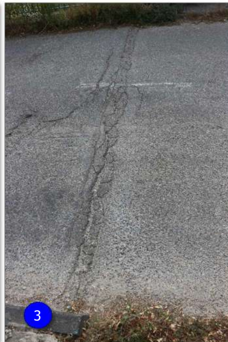
Figure 8 : (1) fissuration du trottoir et peuplier poussant derrière la bordure ; (2) fissuration au-dessus de P1; (3) état du joint de dilatation coté RG.
