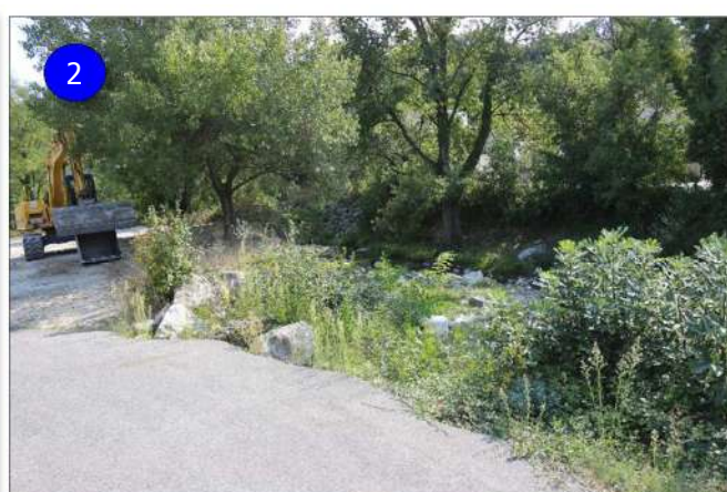
Figure 6 : (1) dos d'âne rabattant les eaux en début de crue ; (2) zone de retour des eaux en lit en aval du dos d'âne
