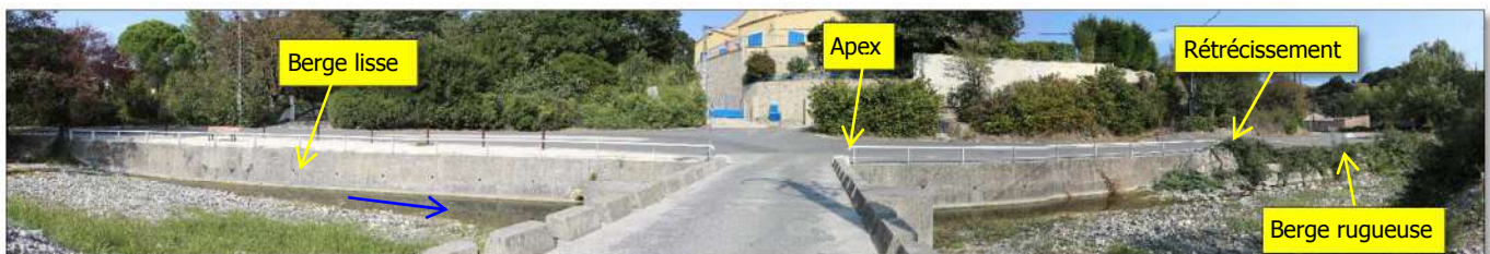
Figure 3 : développé du méandre au niveau du pont à créneaux (attention, le montage informatique des photos lisse l'arrondi du méandre)
