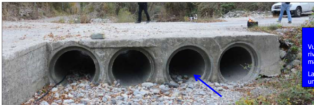
Figure 6 : Vue amont de l'ouvrage aval
