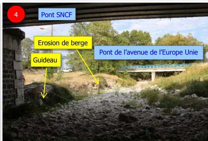
Figure 6 : (1) obstruction partielle de la travée T2 du pont de l'Europe Unie liée aux accrétions générées en RD par le pont SNCF ; (2) accrétions en RD entre les deux ponts ; (3) érosion de berge en aval RG du pont SNCF (zone de réaxement du lit) ; (4) vue depuis la travée T2 du pont SNCF, on voit le mur guideau pour limiter les débordements sur la route, le désaxement et l'érosion de berge
