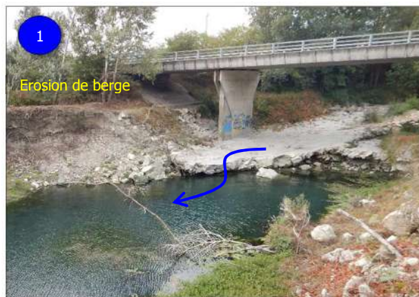
Figure 3 : (1) vue depuis l'aval RG, on note le décroché du lit, la déstructuration du radier ; (2) vue depuis l'aval, on voit la forme en cunette du radier pour diriger le flux et son état. On note également l'érosion de berge en rive droite.
