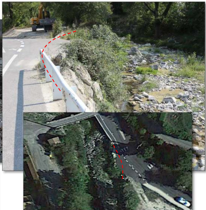
Figure 8 : vue en eau et en assec du rétrécissement en aval rive gauche du pont à créneaux
