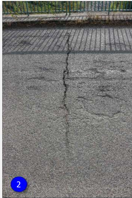
Figure 8 : (1) fissuration du trottoir et peuplier poussant derrière la bordure ; (2) fissuration au-dessus de P1; (3) état du joint de dilatation coté RG.
