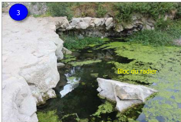
Figure 6 : (1) Etat du bord aval du seuil, le béton de la structure se fissure et se fragmente car le seuil est sous-cavé. Ce denier va progressivement se démanteler ; (2) Vue du sous-cavement aval, une partie résiduelle n'est plus en appui sur le TN et va s'effondrer, (3) et (4) même vue sous différents angles, on remarque un bloc détaché en aval du radier. Actuellement le radier déstructuré n'est pas franchissable par la truite commune.
