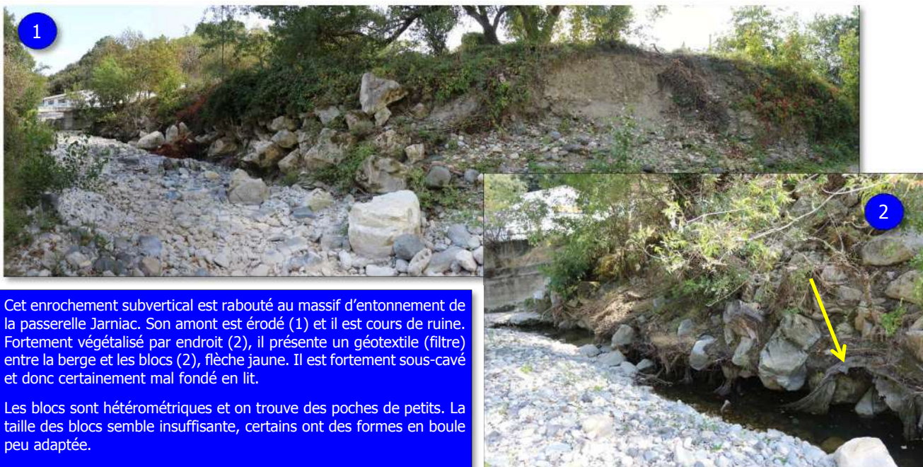
Figure 2 : enrochement en amont rabouté à la passerelle Jarniac en cours de ruine
