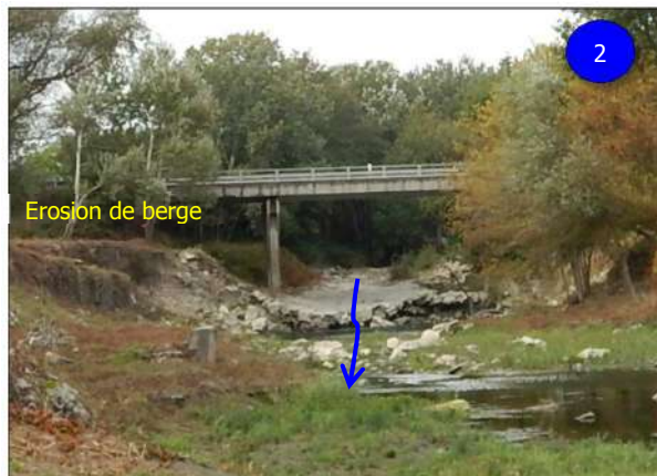
Figure 3 : (1) vue depuis l'aval RG, on note le décroché du lit, la déstructuration du radier ; (2) vue depuis l'aval, on voit la forme en cunette du radier pour diriger le flux et son état. On note également l'érosion de berge en rive droite.
