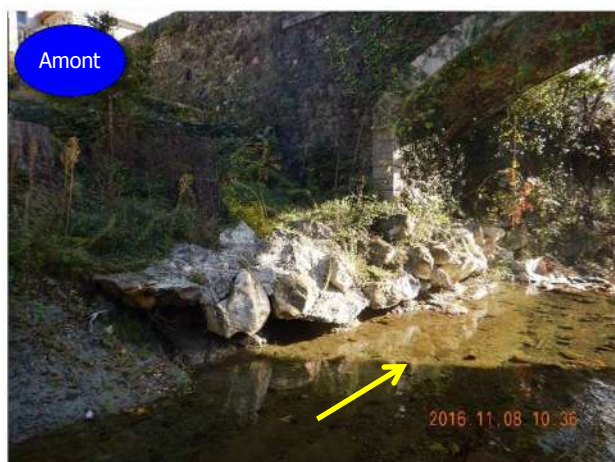
Figure 3 : appuis du pont de la Liberté, à gauche → culée C0 avec massif de renfort sous-cavé ; à droite → pile P1 partiellement reprise par enrochement bétonné
