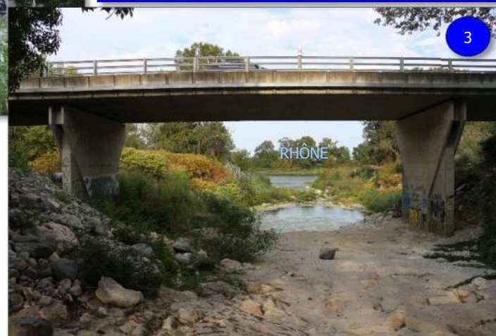
Figure 2 : diverses vue du pont de la RD 86
