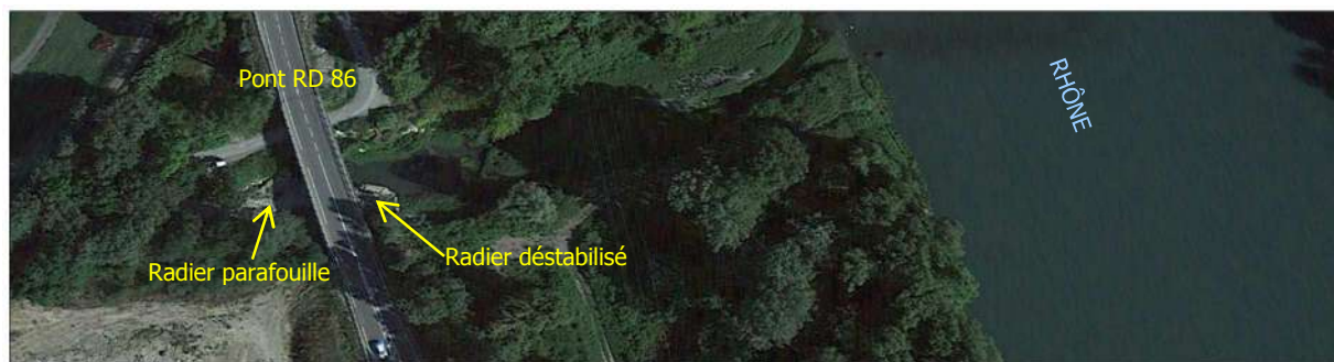
Figure 1 : pont et radier de la RD 86
