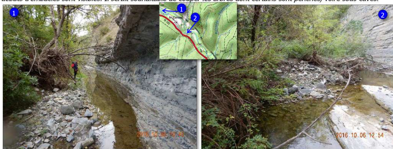
Figure 5 : zone de contraintes latérales favorisant l'embâclage du lit en amont (1) et en aval (2) du gué des Combes
