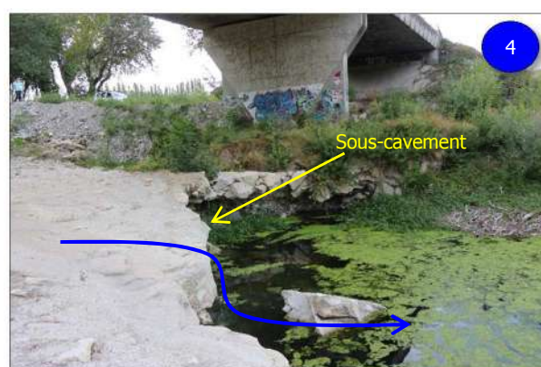
Figure 5 : (1) Vue depuis l'aval, on note l'érosion de berge en aval du reste du radier ; (2) Cette vue montre la fracturation du radier et on voit la forme en cunette pour guider le flux ; (3) La cassure du seuil est bien visible, la confluence est très proche ; (4) le radier apparaît sous-cavé sur cette vue et donc en position de continuer à se ruiner au fil des crues.
