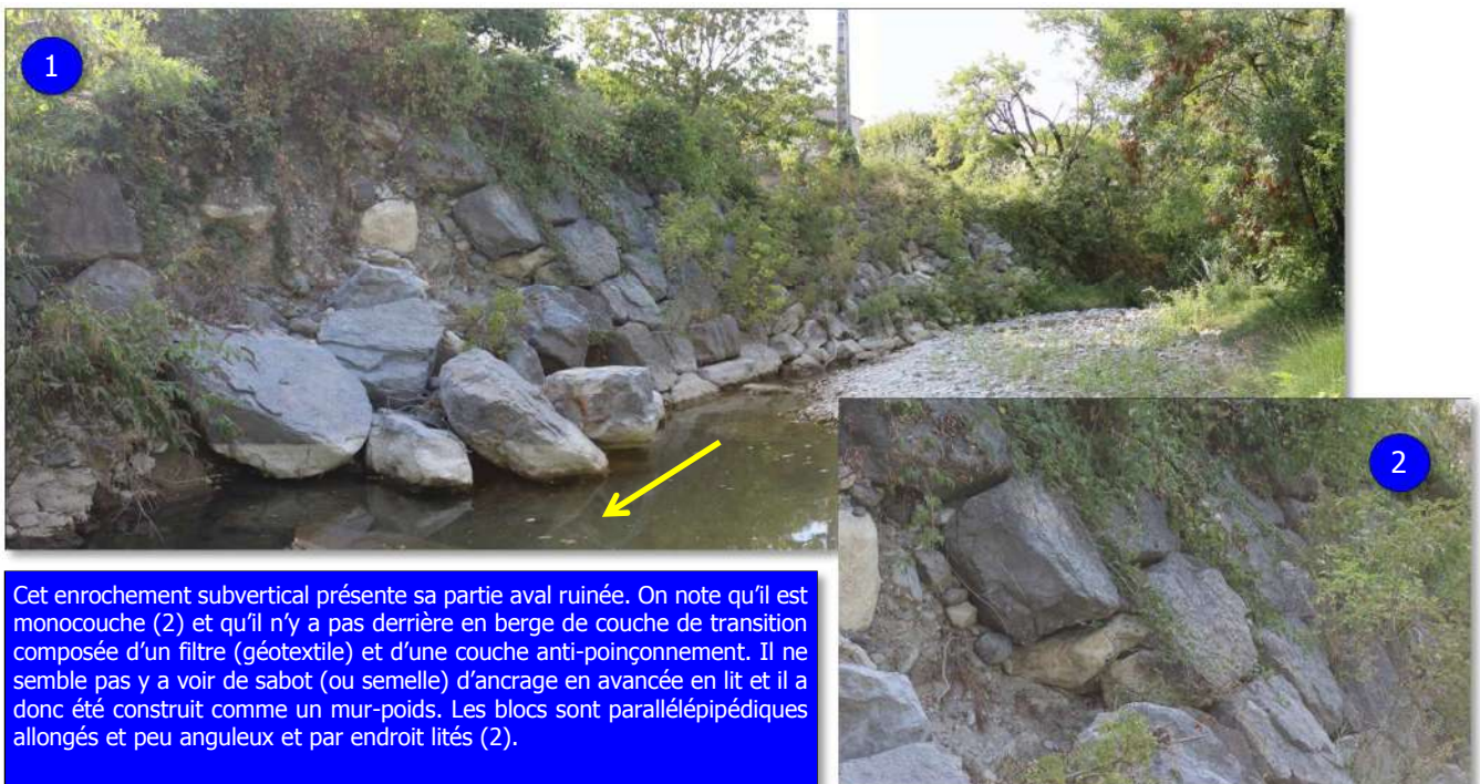
Figure 1 : En haut → enrochement en aval du pont à créneaux partiellement ruiné ; en bas détail de la partie ruinée.
