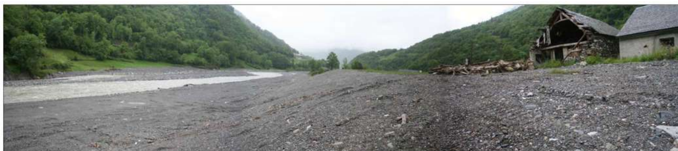
Glacis de recharge (injection-fusible de 6 000 m 3 ) protégeant la route et les habitations (Saligos, gave de Pau, 2012)
