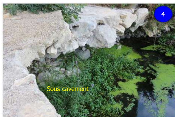
Figure 6 : (1) Etat du bord aval du seuil, le béton de la structure se fissure et se fragmente car le seuil est sous-cavé. Ce denier va progressivement se démanteler ; (2) Vue du sous-cavement aval, une partie résiduelle n'est plus en appui sur le TN et va s'effondrer, (3) et (4) même vue sous différents angles, on remarque un bloc détaché en aval du radier. Actuellement le radier déstructuré n'est pas franchissable par la truite commune.
