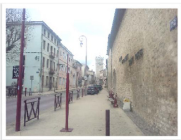
Trottoir aménagé de largeur confortable sur le faubourg de la Cire, y compris derrière les places de stationnement
