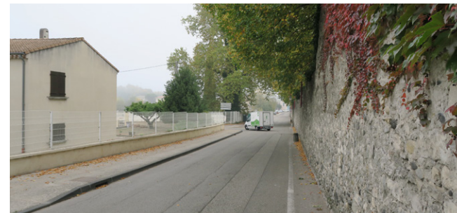
Avenue du Jeu de Mail, sous le mur de clôture du Grand Séminaire... une certaine aridité au niveau du ressenti piéton et de la sécurité
