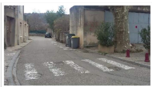
Absence de cheminement piéton pour accéder au parking du Creux et traversée piétonne minimaliste et non accessible
