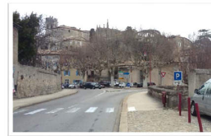
Trottoir aménagé et traversée piétonne accessible sur l'avenue de la Gare, en lien avec le parking existant côté Mairie
