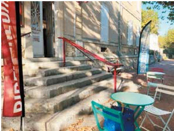
Rampe d'accès bibliothèque.
