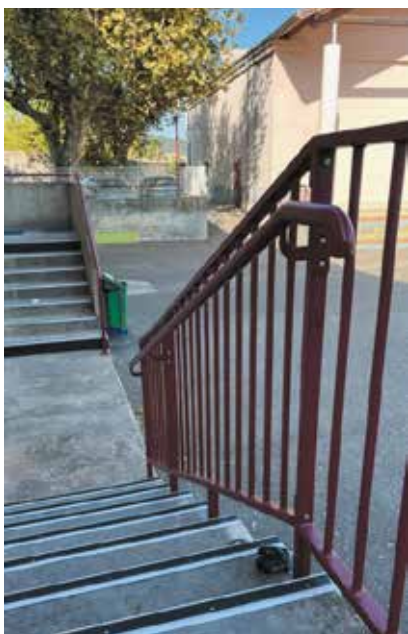
Rampe de sécurité Ecole de la Roubine.
