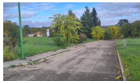
Rue des Vignes, au niveau du projet
