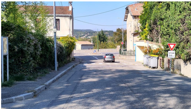
Vue du carrefour depuis l'Avenue du 19 mars 1962
