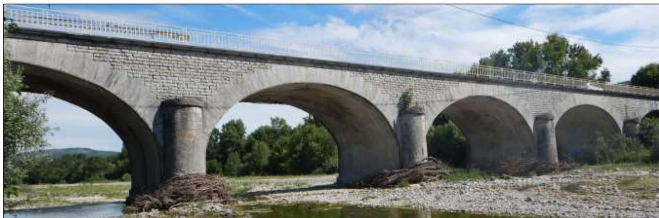
*Vue partielle en élévation du pont de la RD86 depuis l'amont montrant les arches en anse de panier*
