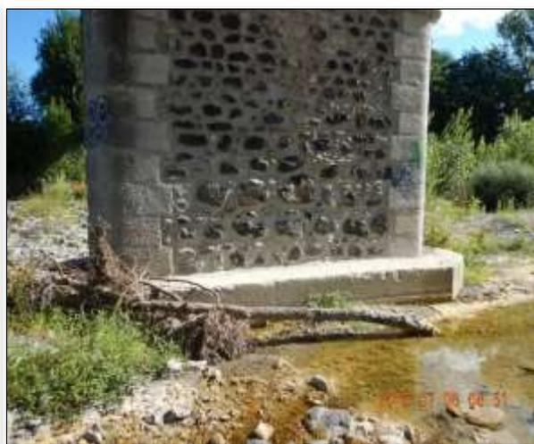
*Érosion de berge suite à la crue de septembre 2015 (à gauche) et pile P4 du pont de la Calade avec semelle de renforcement laissant suspecter un affouillement de l'appui corrigé par la mise en place d'un voile béton (à droite)*
