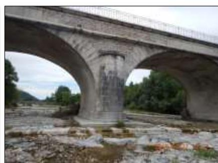
*Pont de la RD 86 : (à gauche) vue depuis l'aval de la culée C0 et de la pile P1, on note le radier en lit et l'affouillement du lit en aval de ce radier (flèche jaune) ; (à droite) vue de la pile P2 depuis l'aval équipée d'une semelle béton destinée à lutter contre l'affouillement (elle a dû être réalisée avant le radier en lit)*
