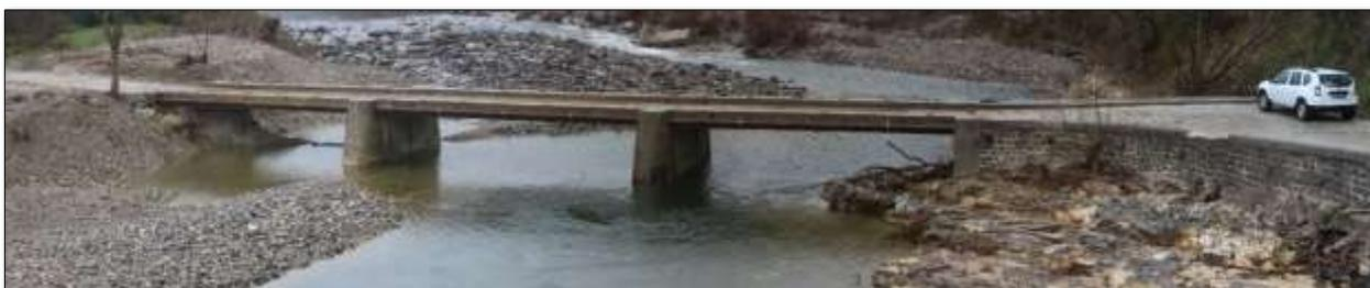
*Vue en élévation depuis l'aval du pont Marquet en février 2016. On note la culée de rive gauche prolongée par un bajoyer en maçonnerie de moellons. Cette culée est en appui sur une passée calcaire.*
