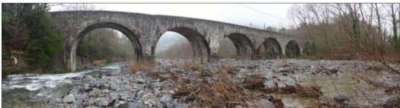
*Vue depuis l'amont du pont La Roche. On note les six travées et cinq piles de l'ouvrage. Le lit est déporté et s'écoule vers la rive gauche au contact de la culée C0.*
