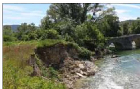
*Affouillement en pied de culée C0 à inspecter laissant suspecter un risque de ruine de C0 (à gauche) et érosion en berge montrant un risque de contournement de l'ouvrage côté culée C0 (à droite)*
