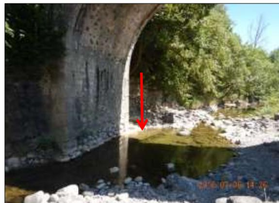
Pont La Roche : vue de la culée C0. Depuis la reprise de l'enduit, il semblerait que le lit se soit incisé. En effet, la partie basse présente un disjointement important des maçonneries (on peut donc penser qu'elle devait ainsi être enfouie sous les sédiments lors de la réalisation de l'enduit du piédroit). On aperçoit un confortement de la culée (semelle), réalisé suite à un affouillement du lit (flèche).
