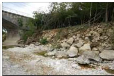
*Pont SNCF : (à gauche) vue de la travée T5 et culée C5, on note l'érosion de berge en aval de l'ouvrage (flèche) et d'une ancienne pile proche de C5 ; (à droite) enrochement d'entonnement déstructuré*
