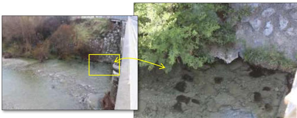
*Vue générale de l'entonnement de la culée C0 (à gauche) et vue en gros plan de l'affouillement (à droite)*
