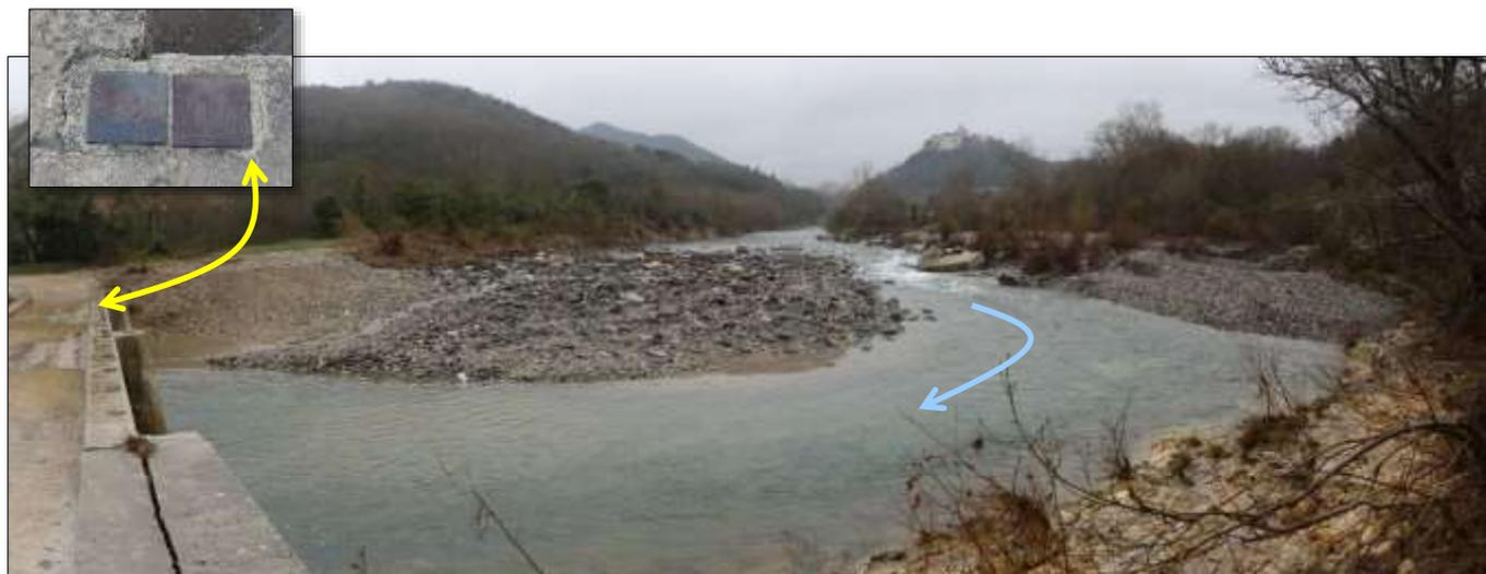
*Vue depuis la culée C0 du pont Marquet en février 2016. Le méandre venant buter sur la passée rocheuse en rive gauche est bien visible, ainsi que l'atterrissement devant la travée T3. On note sur la longrine chasse-roues des platines témoins des ancrages d'un parapet retiré (flèche jaunes et photo incrustée). La berge de rive droite a fait l'objet de travaux de talutage et l'atterrissement a également été travaillé suite à la crue de septembre 2015.*
