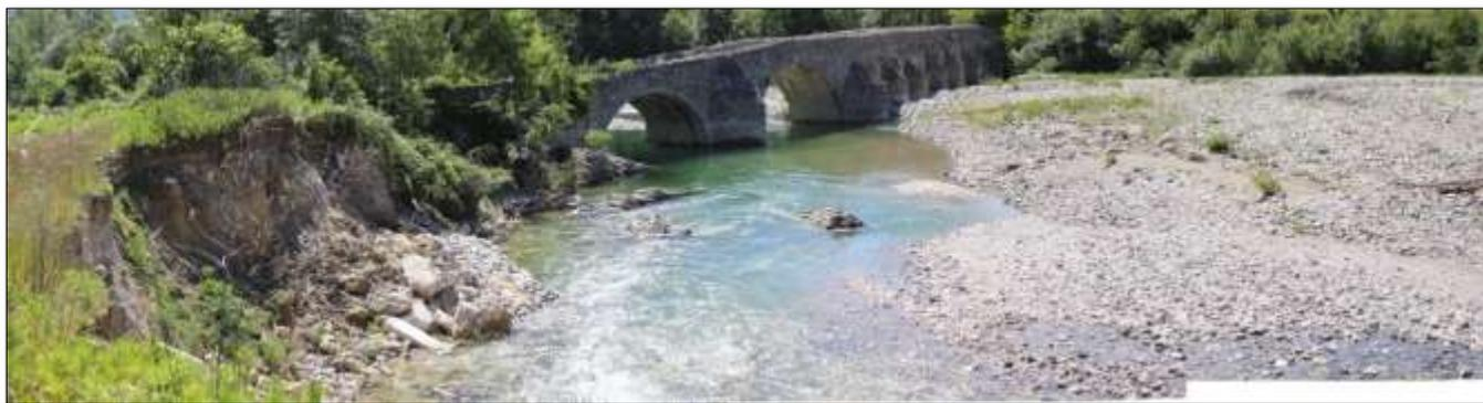
*Gros plan sur la partie distale de l'érosion et du méandrage de l'Escoutay. La culée C0 est sollicitée avec risque à terme de ruine partielle de l'ouvrage et de contournement.*
