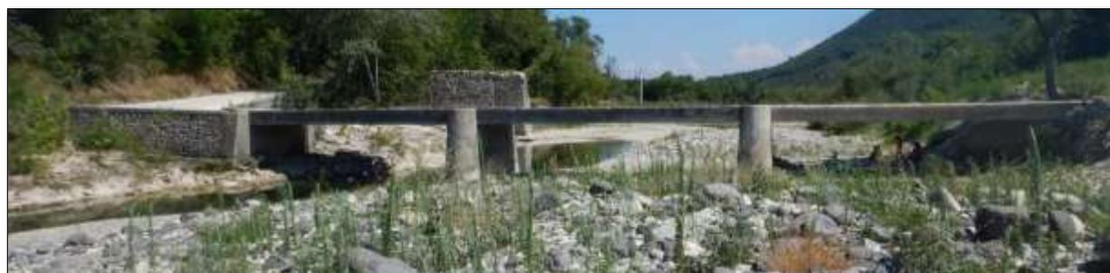
*Vue en élévation depuis l'amont du pont Marquet en juillet 2016. On note le basculement du lit vers la rive gauche et l'atterrissement devant les travées T2 et T3.*
