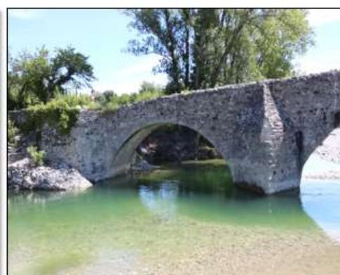
*État de la culée C0 à surveiller (à gauche) et vue des appuis de rive gauche (C0 et P1). Le lit s'est approfondi par affouillement lié aux ressauts engendrés par les appuis. Les sous-faces d'appuis sont-elles décaissées ? Seule une inspection détaillée permettra de le savoir.*
