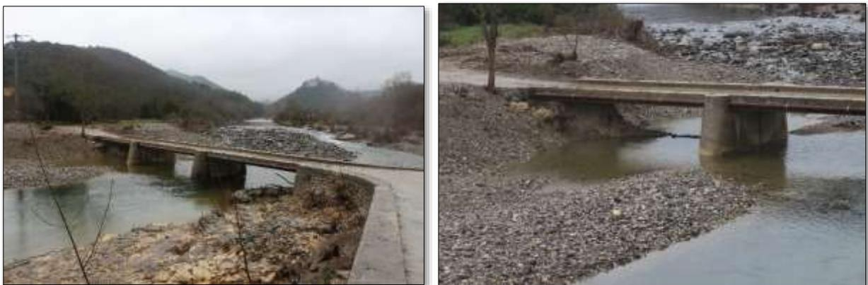
Figure 11 : Vue depuis l'aval du pont Marquet. Travaux de libération de la travée T3 (à gauche) et de retalutage de la berge (à droite)
