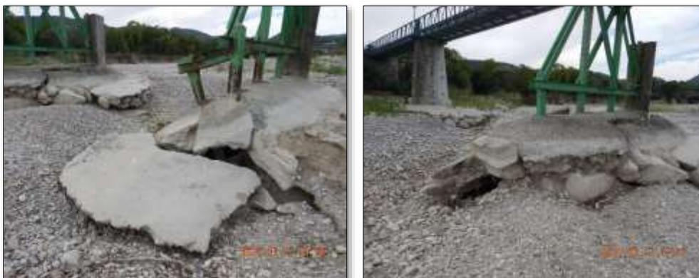
*Figure 6 : Passerelle de la Moutte, état des appuis déstructurés (semelle béton affouillée et partiellement ruinée, palée d'appuis tordue sur la photo de droite...). Des travaux de réparation ont été réalisés récemment.*
