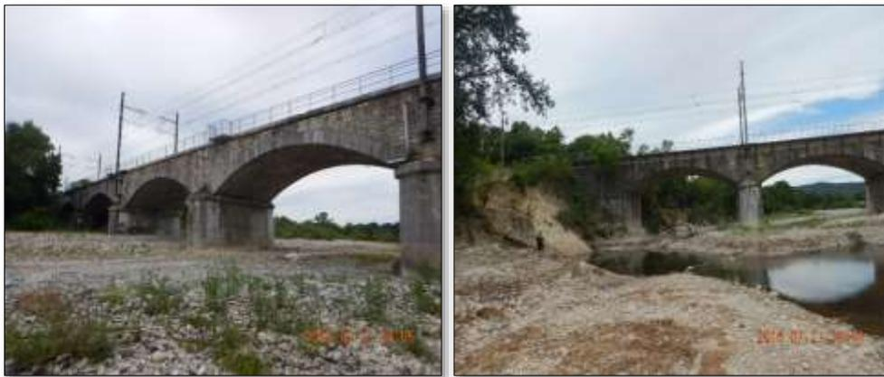
*Figure 5 : Vue générale du pont de la SNCF (à gauche) et érosion de berge au contact de la culée du pont côté rive gauche*
