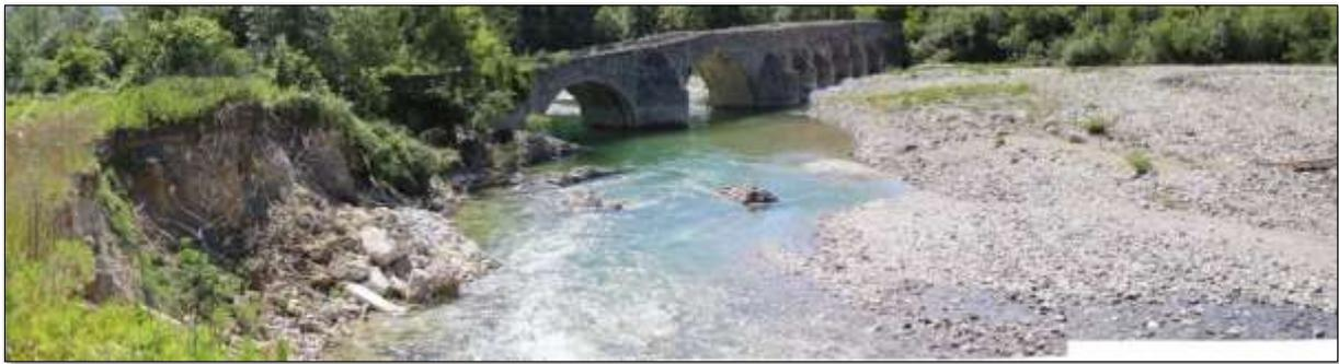
Figure 9 : Vue du pont Romain depuis la rive gauche. On note l'érosion de berge et l'atterrissement favorisant le déport vers la berge de rive gauche.
