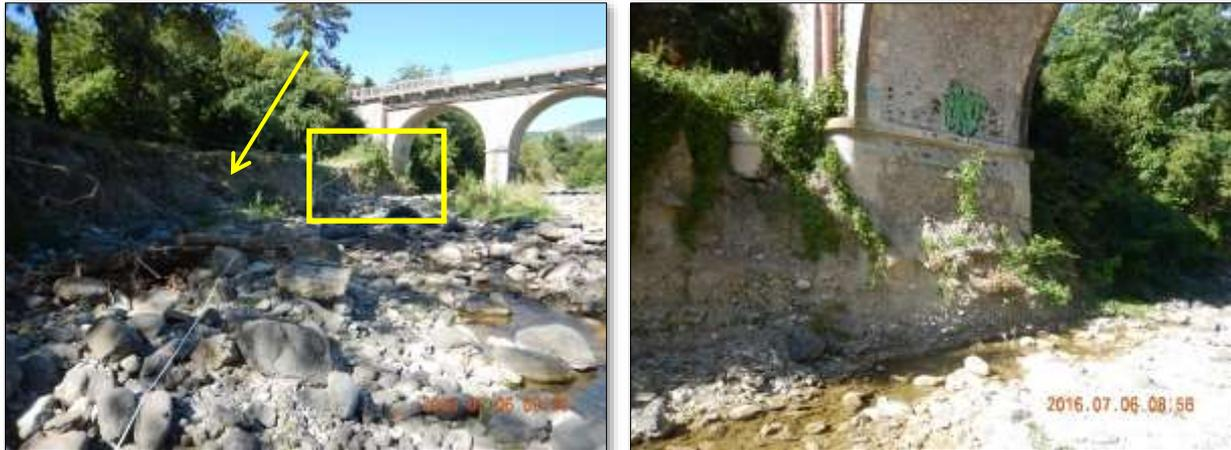
Figure 7 : Érosion de berge en aval du pont de la Calade (flèche jaune) (à gauche) et érosion côté culée C5 (gros plan correspondant au cadre jaune de la photo de gauche) (à droite)
