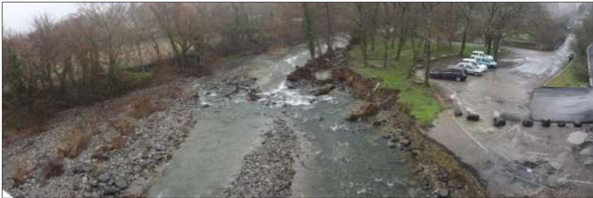
Figure 8 : Érosion de berge en aval du pont de la Calade suite à la crue de septembre 2015
