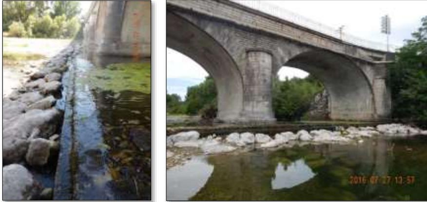
*Figure 4 : Pont de la RD 86, radier généralisé aménagé pour lutter contre l'effet de l'incision du lit sur les appuis de l'ouvrage (piles et culées)*
